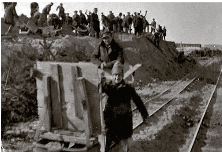
Na placu budowy
