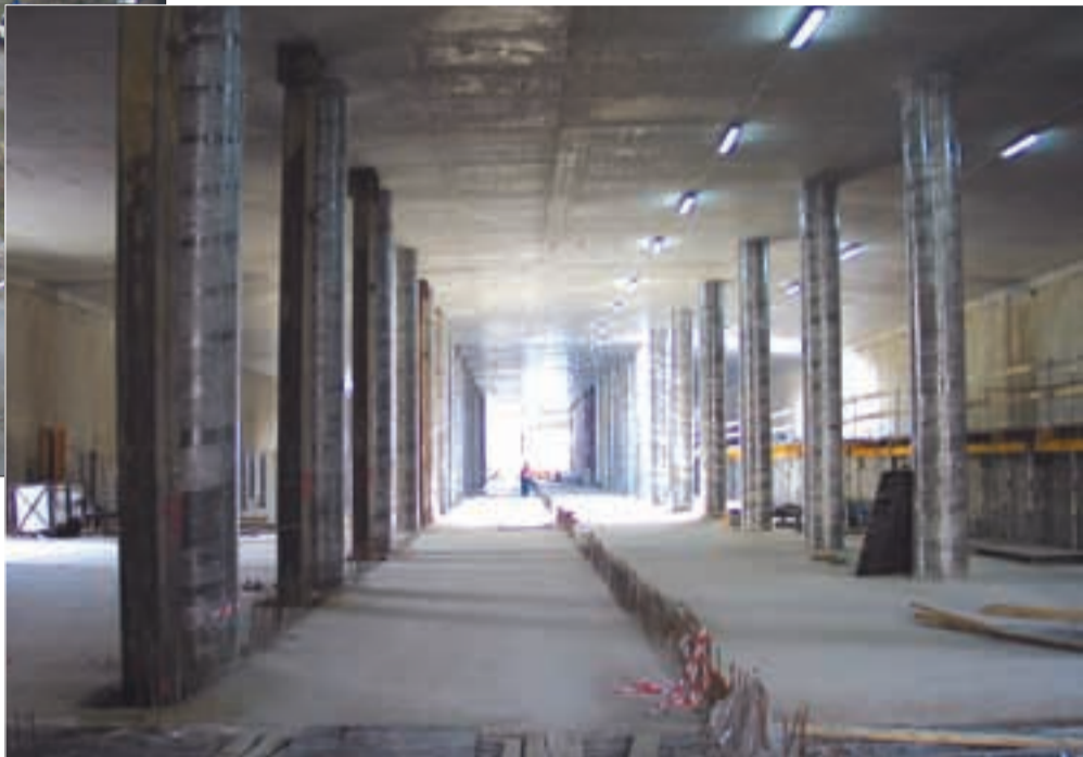
Wnętrze stacji Słodowiec
