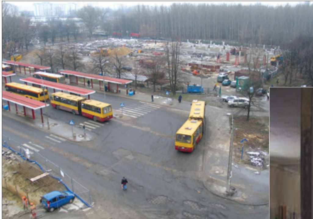
Budowa węzła komunikacyjnego
