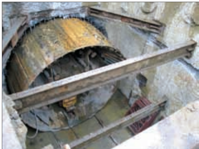
Tarcza skończyła pracę – przebiła tunel
